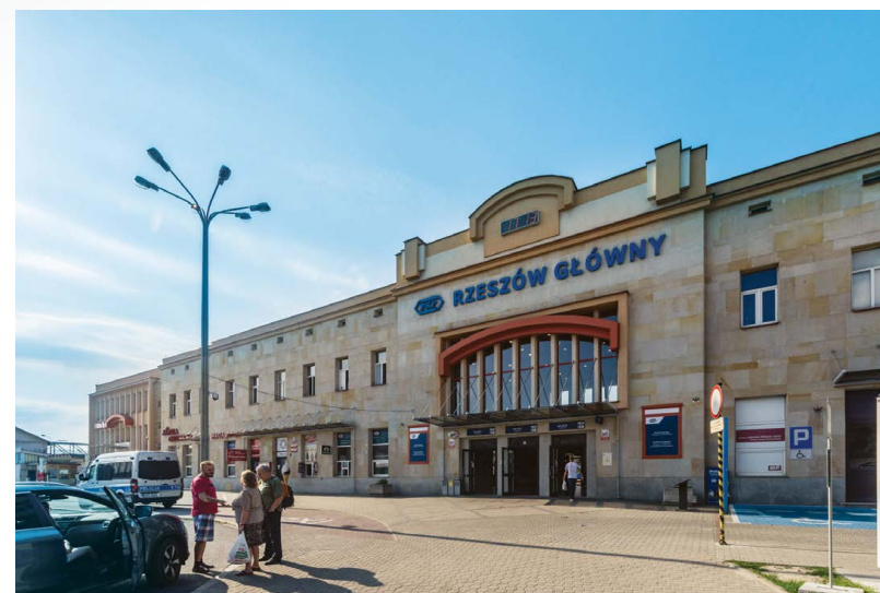
Železničná stanica v Rzeszowe
